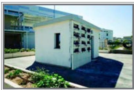
Aspecto final de la casa piloto impresa por Be More 3D en 2018. (Be More 3D)
